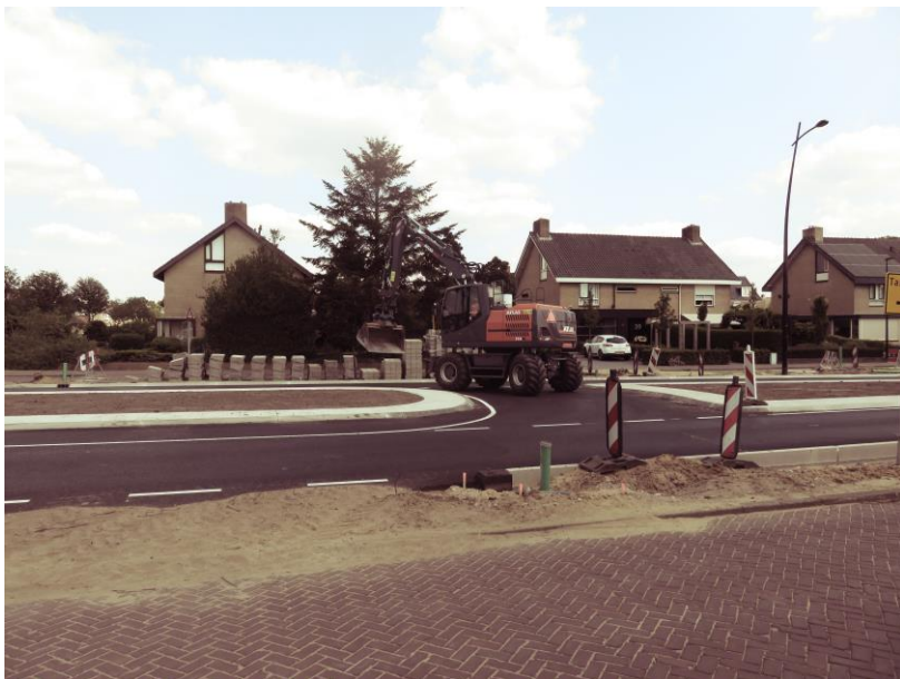
Werkzaamheden aan de Voorthuizerstraat verlopen voorspoedig.
